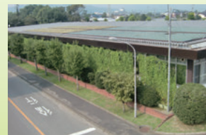
事務所棟のグリーンカーテンと屋上緑化
